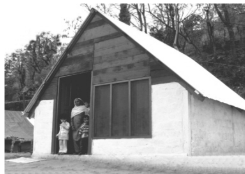
Einige Häuser, hoch in den Bergen, sind bereits fertig. Eine Mutter kam Nils Stilke entgegen gelaufen und bedankte sich unablässig für die Hilfe von humedica.
